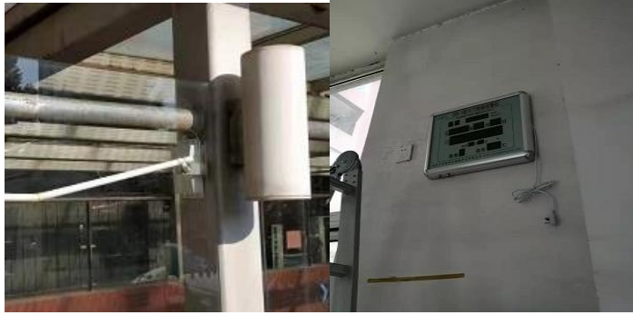
图 4-1 新增的 4 套固定式剂量监测报警装置照片
